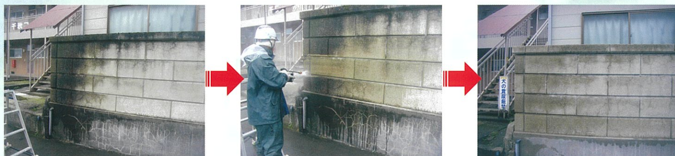
特殊な高圧洗浄機で きれいに清掃
